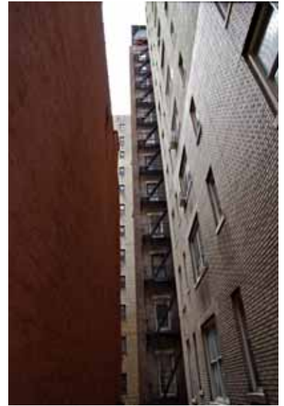
En blick in mellan två husväggar. Brandtrappor.
